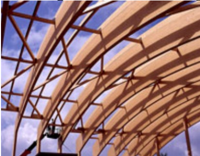
Bild 23: Dachtragwerk aus dem Holzwerkstoff Brettschichtholz
